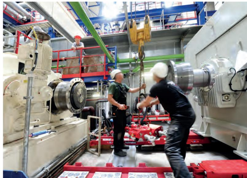
23.07.2015: Die Firma SIEMENS wechselt einen der Generatoren.
